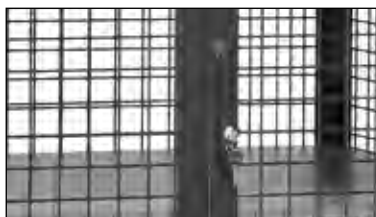
Treibriegelverschluss mit Schwenkhebel und Zylinderschloss.
